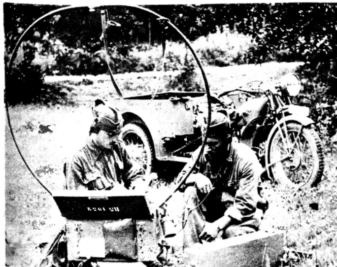
Un puesto de radiotelefonía por onda ultracorta que puede transportarse en motocicleta. El Ejército italiano está dotado con millares de puestos de esta clase.
